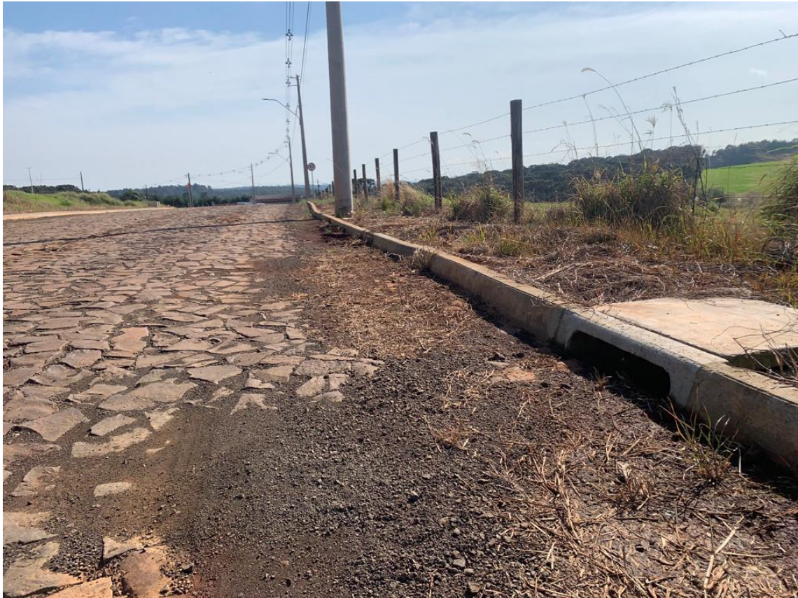
Figura 18: Drenagem com meio-fio e boca-de-leão, na frente do imóvel.
