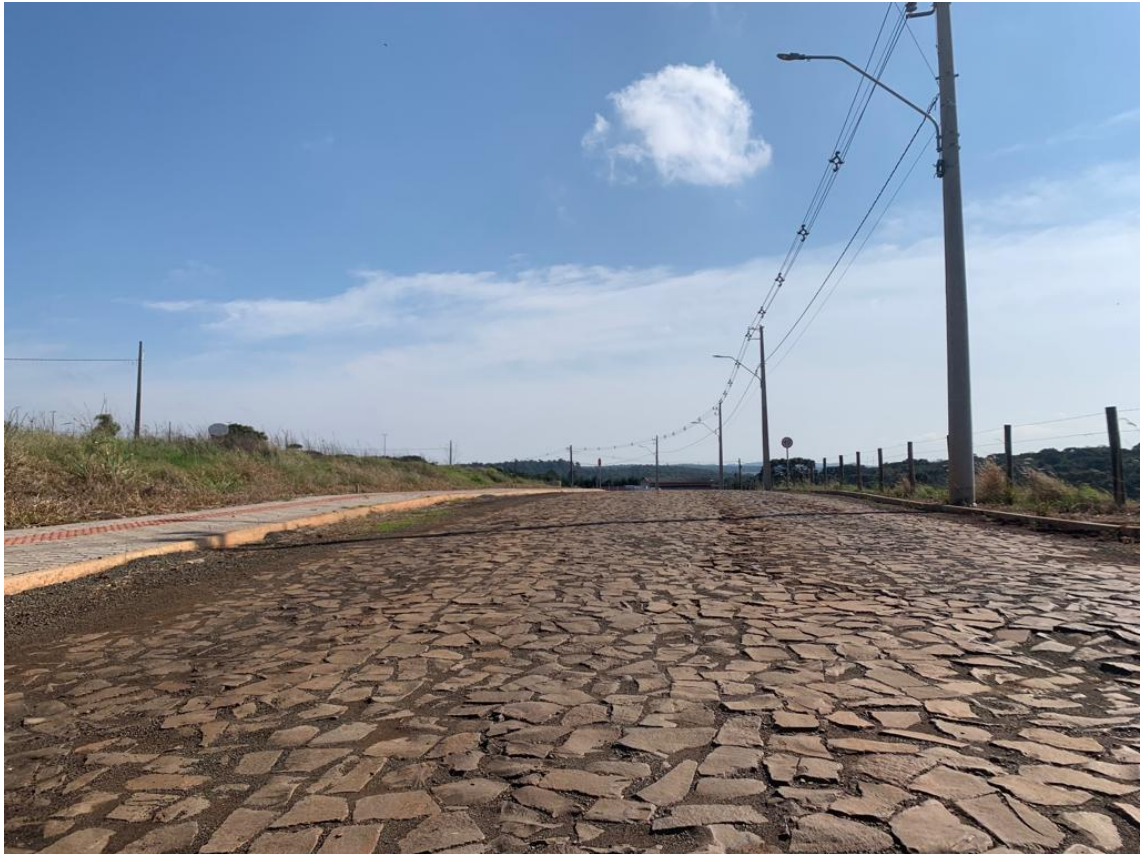
Figura 19: Via com pista pavimentada em pedras irregulares, na frente do imóvel.
