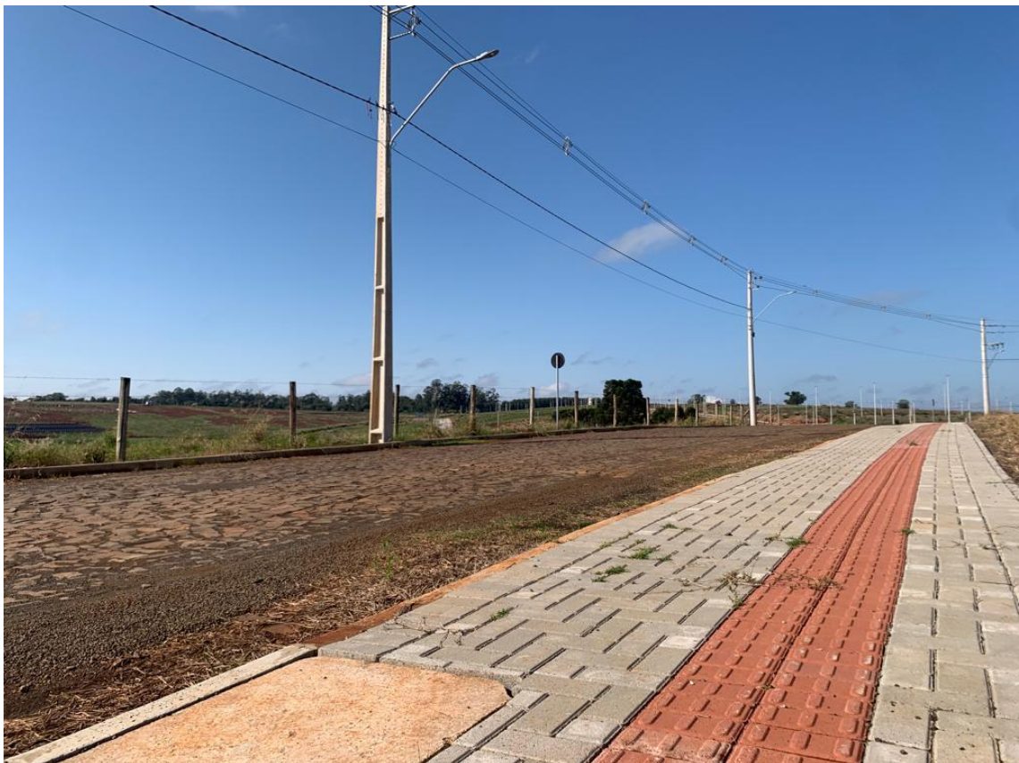
Figura 22: Calçada em paver acessível conforme NBR 9050 em uma lateral da via de acesso.
