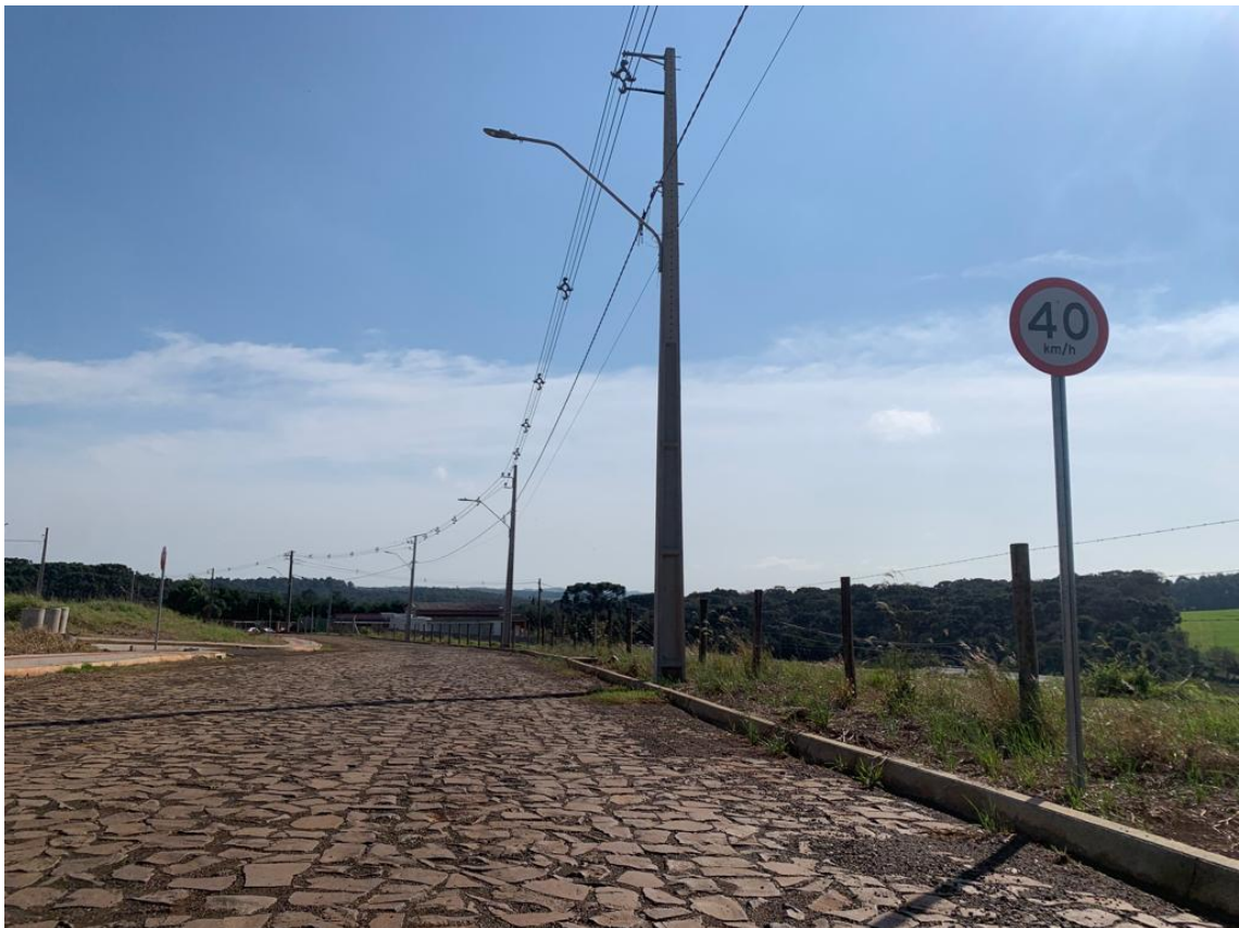
Figura 20: Via pavimentada em pedras irregulares, com sinalização, rede de energia e iluminação pública, na frente do imóvel.
