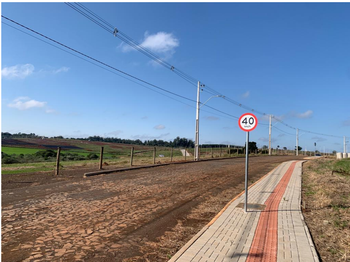
Figura 17: Via pavimentada, sinalizada, rede de energia, meio-fio e passeio.
