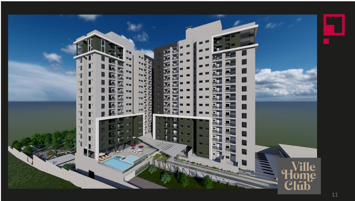
Figura 04 – Vista das torres A e B da projeção do empreendimento Ville Home Club.
