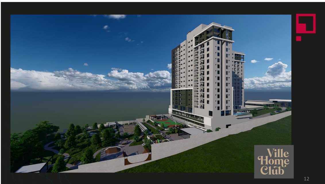
Figura 05 – Vista da torre B e área de vivência da projeção do Ville Home Club.
