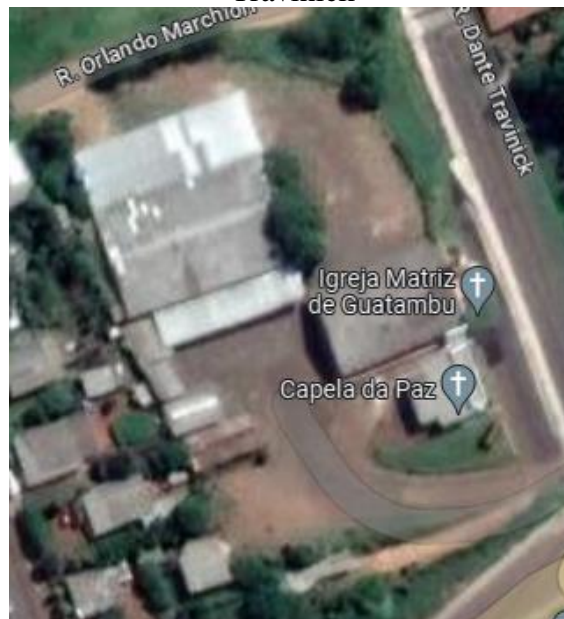
Figura 21. Pavilhão da Capela São Miguel Arcanjo – R. Orlando Marchiori esquina com R. Dante Travinick
