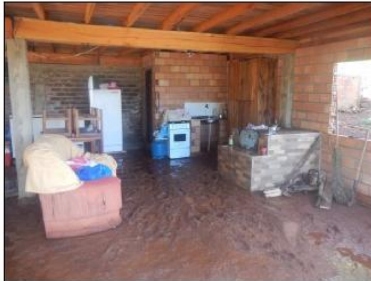
Figura 10. Setor de risco 06
