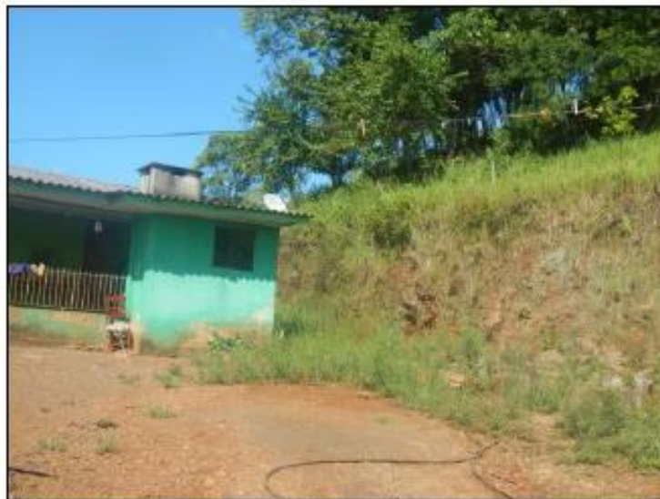
Figura 12. Setor de risco 08
