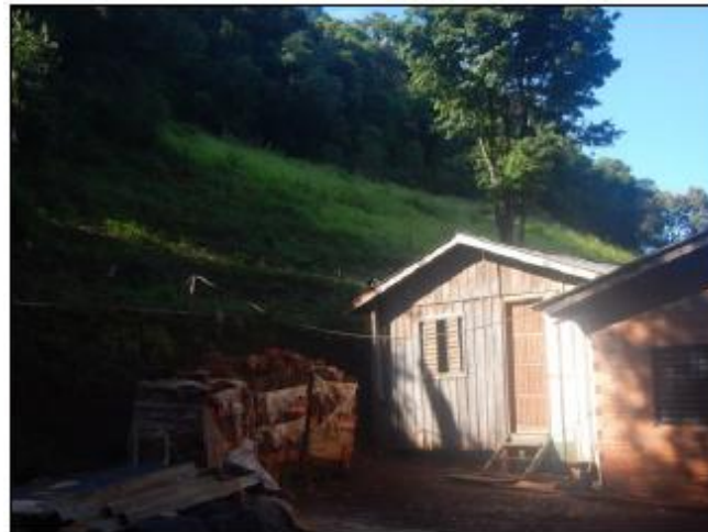
Figura 9. Setor de risco 05
