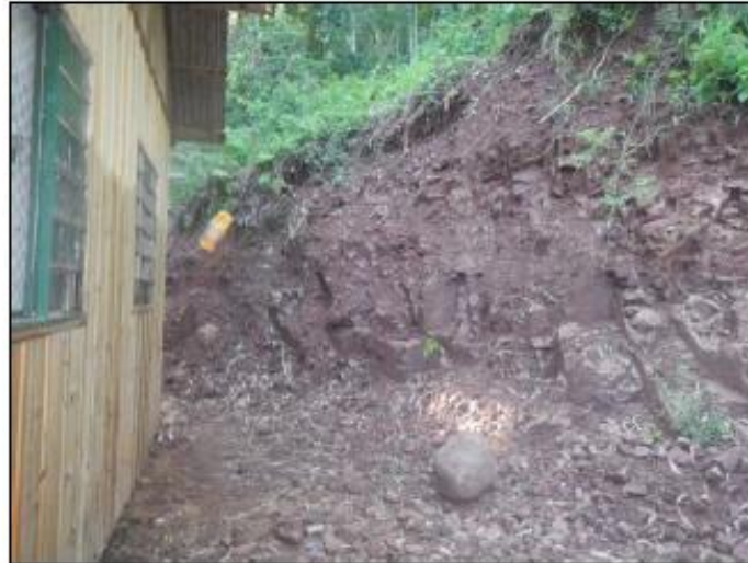
Figura 8. Setor de risco 04
