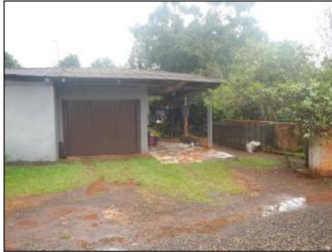
Figura 5. Setor de risco 01
